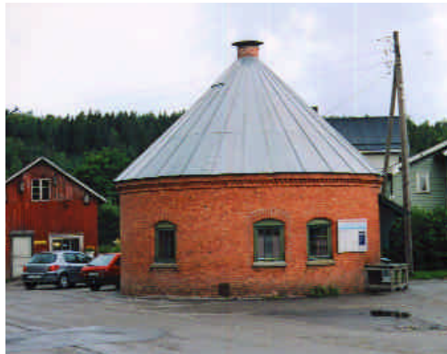
“Brannbrønnen” er en spesiell liten bygning som nå er tatt i bruk av busselskapet. Bygningen har stor betydning for miljøet i Torggata.
